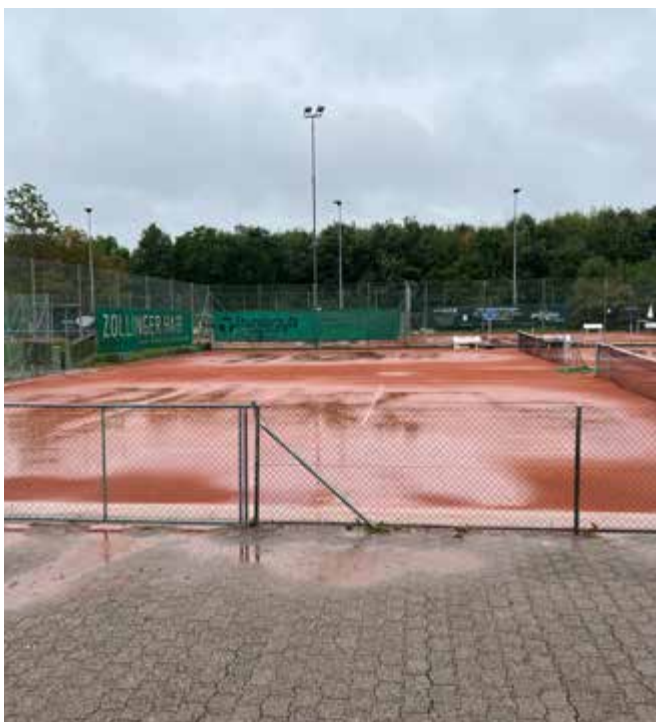
Der verregnete Platz vor der Renovation ...
